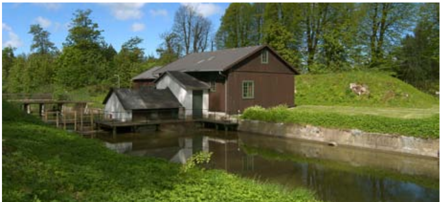
Sluse ved Krudtværket. Foto: Krudtværksmuseet.
